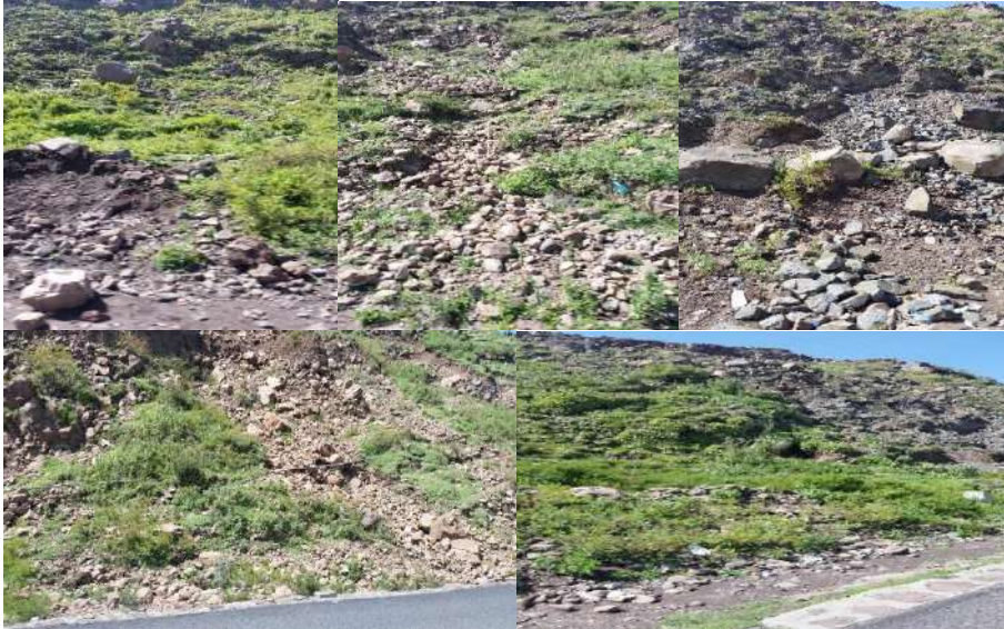
لوحة (13): نماذج لحالات زحف الصخور والحطام من على المنحدرات المطلة على الجانب الأيمن لطريق نقيب شمارة في المنطقة الرابعة. المصدر: الدراسة الميدانية بتاريخ 2021-8-12م.
